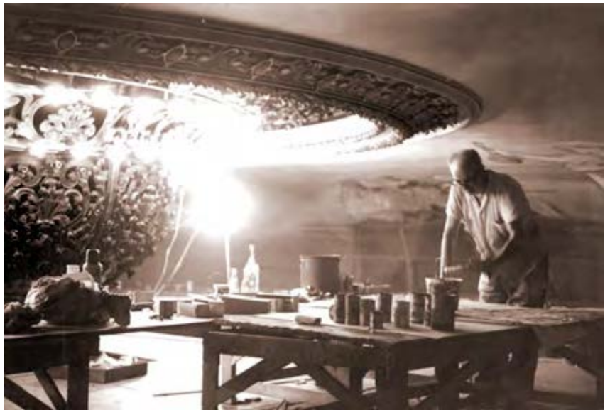
Soldi trabajando en la cúpula del Teatro Colón.
