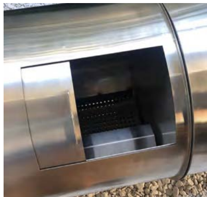
Detalle de la instalación de acero que mide 70 metros aproximadamente.
